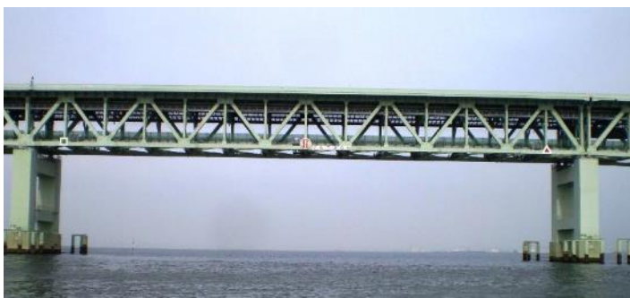
(写真 2) 通過ゲート全体
