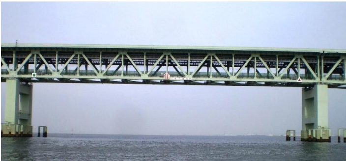
(写真 2) 通過ゲート全体
